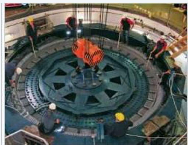
Slika 28. Vađenje rotora hidrogeneratora kod popravka (remonta)<sup>60</sup>
