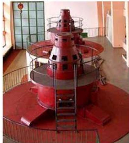
Slika 1.2. Hidrogenerator
