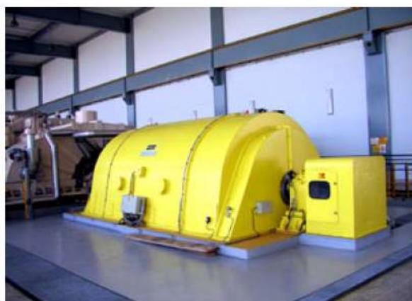
Slika 1.1. Turbogenerator
